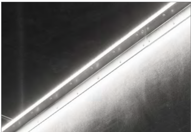
13 Освещение внутри фургона светодиодная лента, смонтированная на потолке с правой стороны. Включение/выключение света производится кнопкой из кабины автомобиля.
